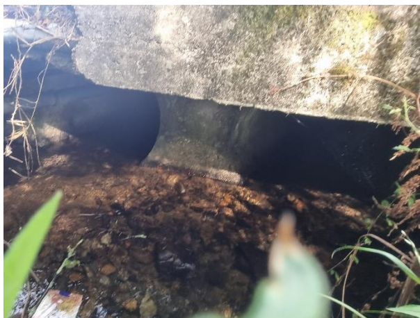
Imagen 37. AC-550 PK 63+735, dos tubos de 1000 mm en Rego de Brión.
